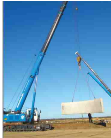
SWTC75在澳大利亚施工工地 SWTC75 Construction In Australia
