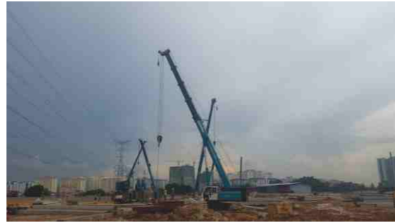
SWTC75在马来西亚施工工地 SWTC75 Construction In Malaysia
